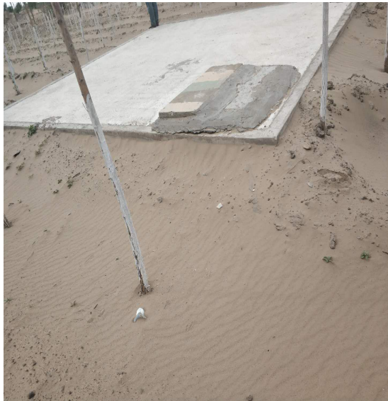
渗滤液收集池
