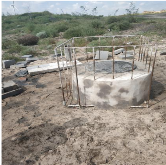
场区西南侧监测井
