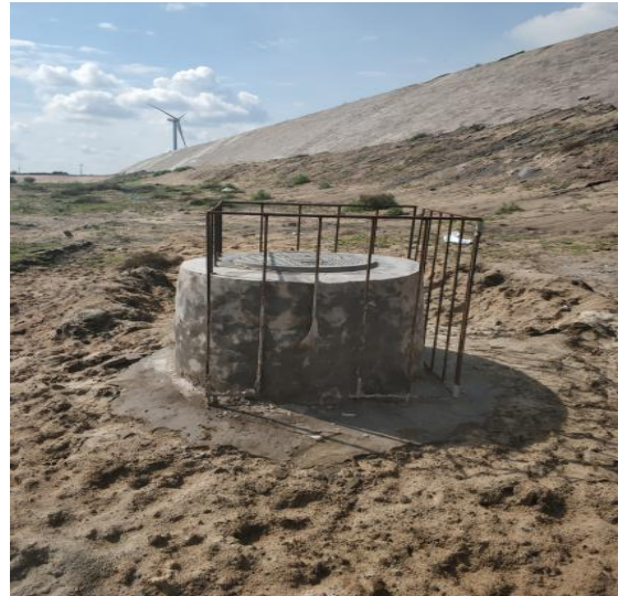
场区北侧监测井
